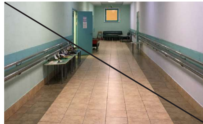
Плохо Керамогранитная плитка с крупными швами
